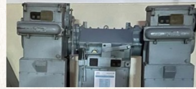
MEI Make Ring Main Unit جهاز وحدة التغذية الحلقية من شركة EMI استخدم هذا الجهاز في المحطات الفرعية ذات الجهد المتوسط لربط المحطات ببعضها.
